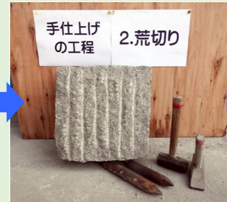
仕上げたい高さの少し上の場所までノミで縦目の溝を作る。
