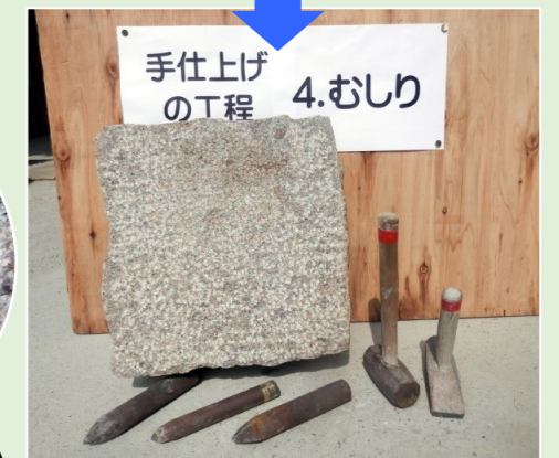
荒むしりのできたコブをノミでさらに細かくむしる。「むしり仕上げ」
