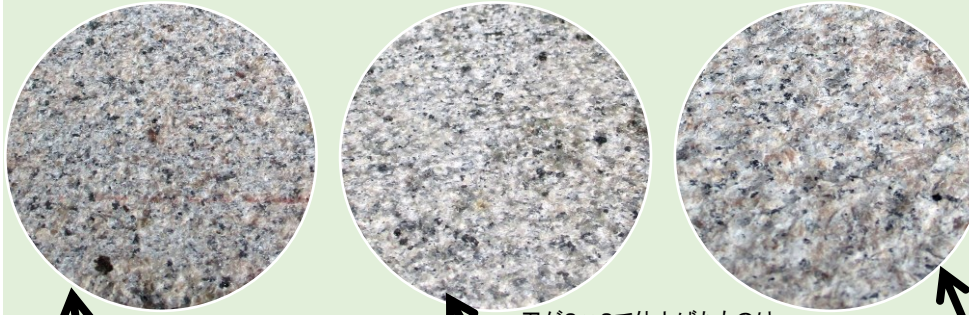
仕上げ目の拡大写真
